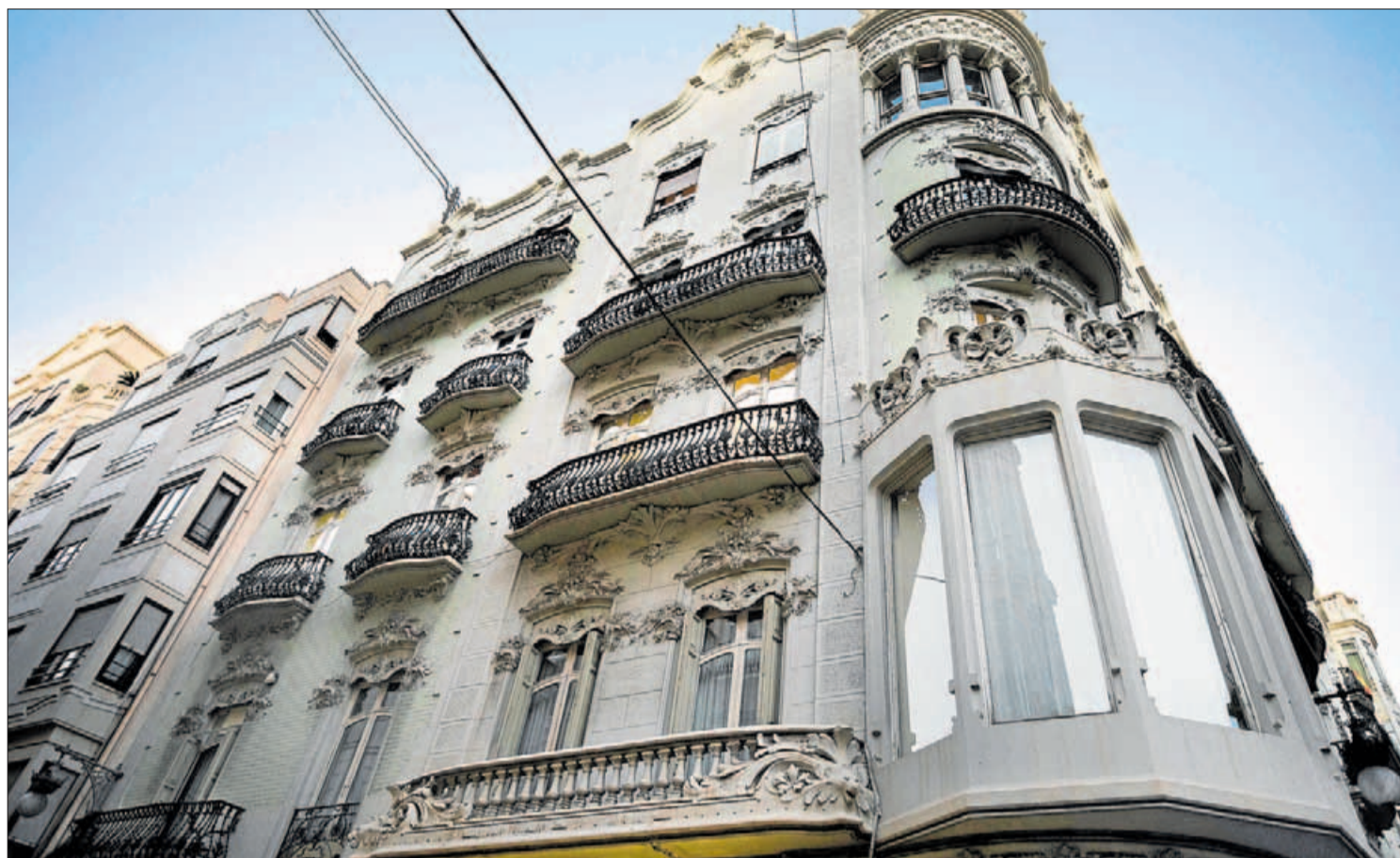
Edificio de la calle de las Comedias con la vivienda más cara de València. GERMÁN CABALLERO
